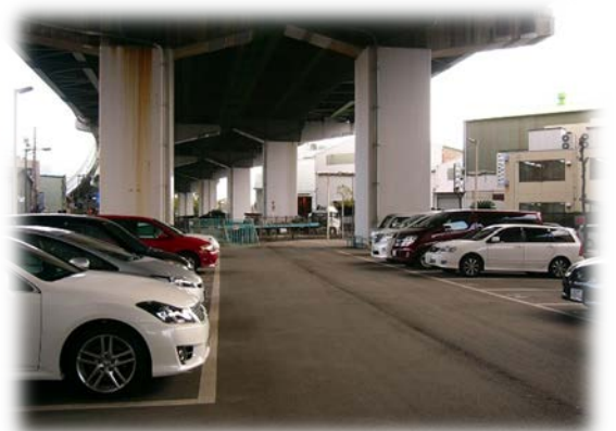
高架下駐車場管理運営
